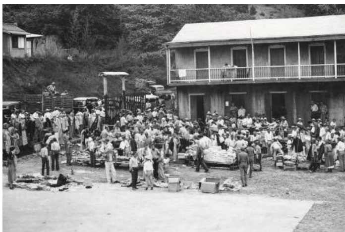
Figura 4. Proyecto de la Puerto Rico Reconstruction Administration (PRAA), Castañer.
