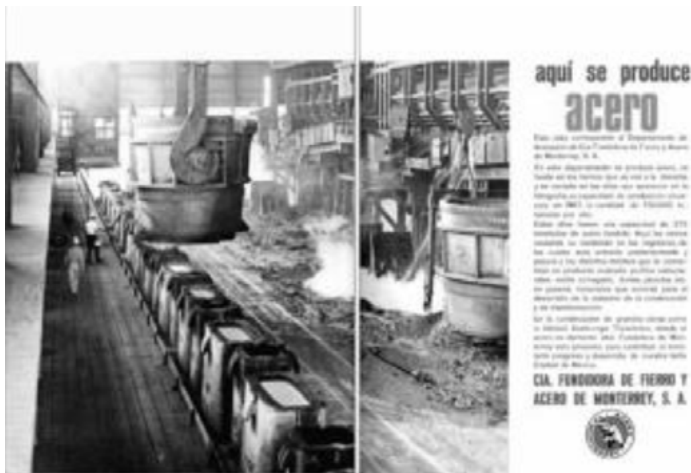
Figura 14. Nuevas instalaciones del Departamento de Aceración. Publicidad a doble página en Arquitectura México
