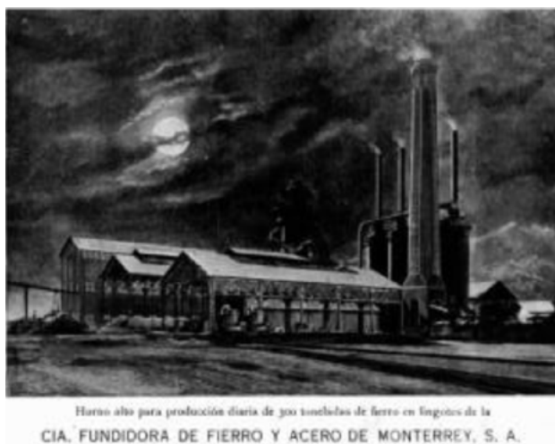
Figura 1. Alto Horno 1 y sus equipos auxiliares: sus cuatro estufas, casa de calderas, casa de sopladores y chimenea
