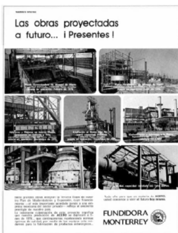
Figura 16. Últimas obras de la tercera fase del plan de expansión y modernización de Fundidora
