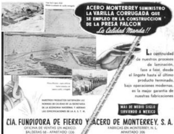
Figura 10. Varilla corrugada de la Fundidora Monterrey para la construcción de la Presa Falcón, importante obra de ingeniería de la frontera norte de México
