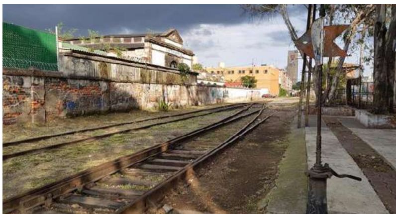
Fotografía 6. Vías de la vía de tren y de la fábrica La Maravilla en la colonia Atlampa
