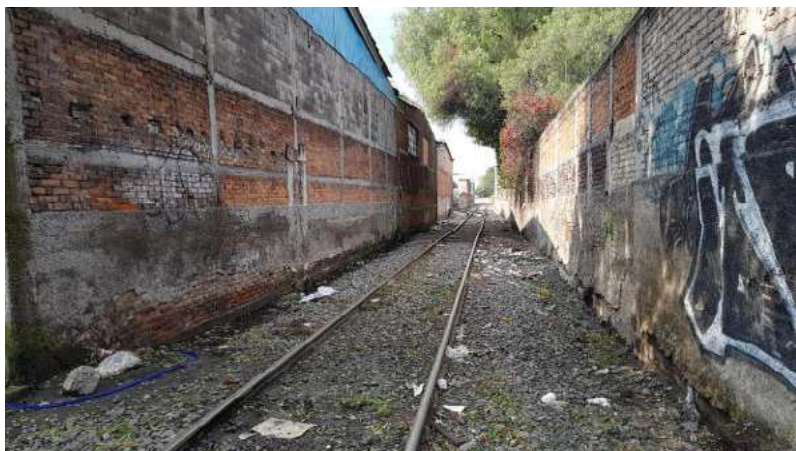
Fotografía 1. Vías del ferrocarril en desuso en la colonia Industrial Vallejo
