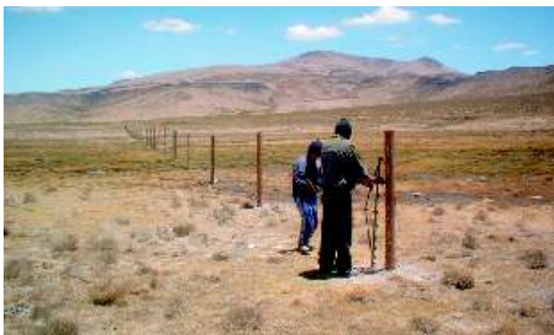
Instalación de cercos de malla.
