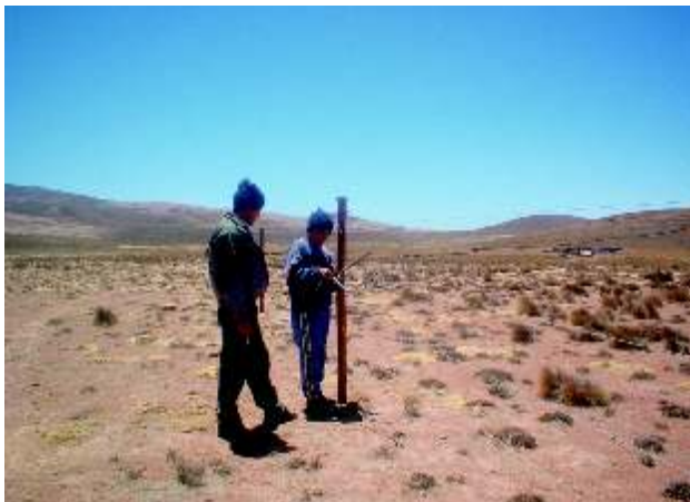
Construcción de cerco de alambre.
