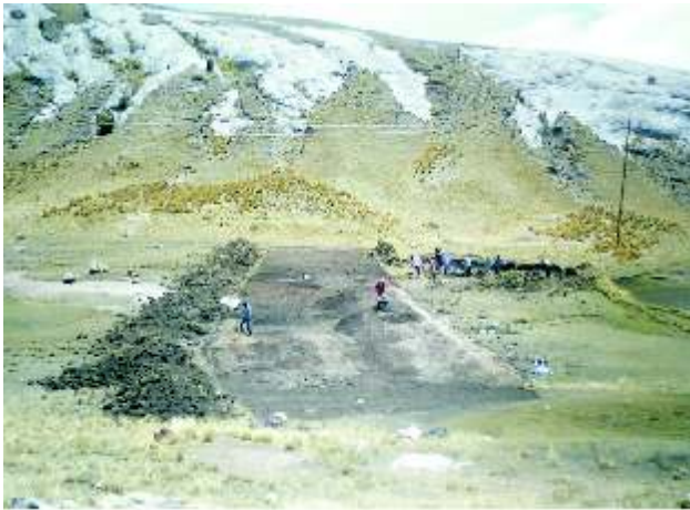
Limpieza de área de construcción.
