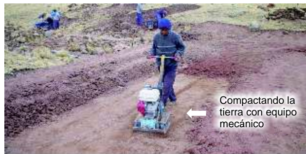
Compactación con motocompactora.
