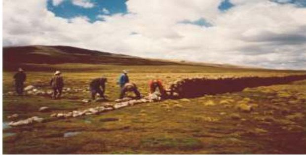
Construcción de cercos de piedra de doble hilera.
