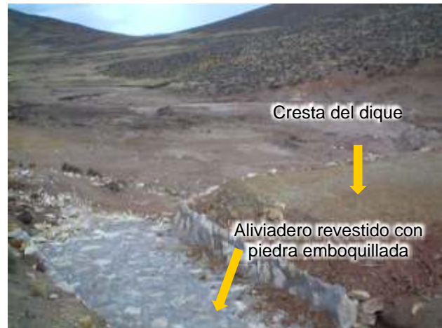
Aliviadero microrrepresa Ccacasuico, Chalhuanca, Caylloma.
