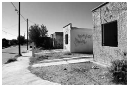
Foto 2. Fuente: Taller de arquitectura del paisaje, calle entre dos terrenos baldíos al Nororiente, Ciudad Juárez, noviembre, 2011. Técnica digital. Archivo de la MPDU.
