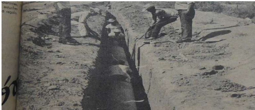
Figura 11. Trabajos en el Paseo La Saucedá
