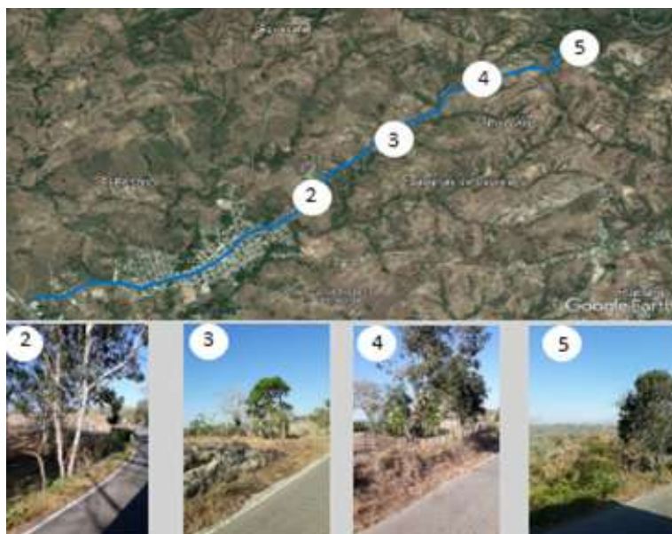
Imagen 10. Carretera vía Morroa - Colosó.
