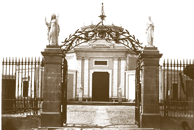
FIGURA 3. Capilla del Cementerio General de Lima.
