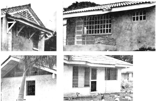
Imagen 17. Comparativa de las soluciones arquitectónicas de ventilación de las viviendas de Betania diseñadas por Rosa (arriba) y Arneson (abajo)
