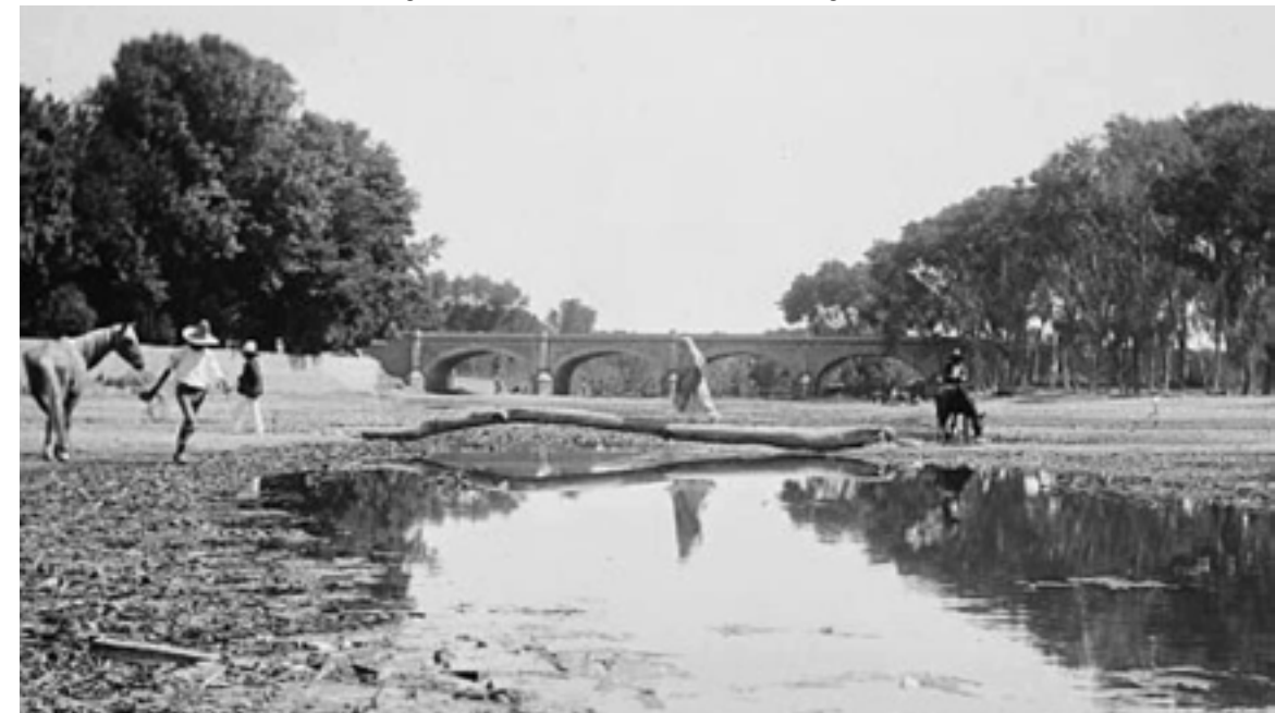
Figura 3. El Puente Grande sobre el río Lagos
