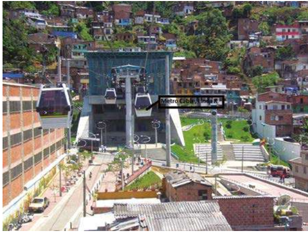
Figura 6.8. Estación Santo Domingo del Metro Cable.
