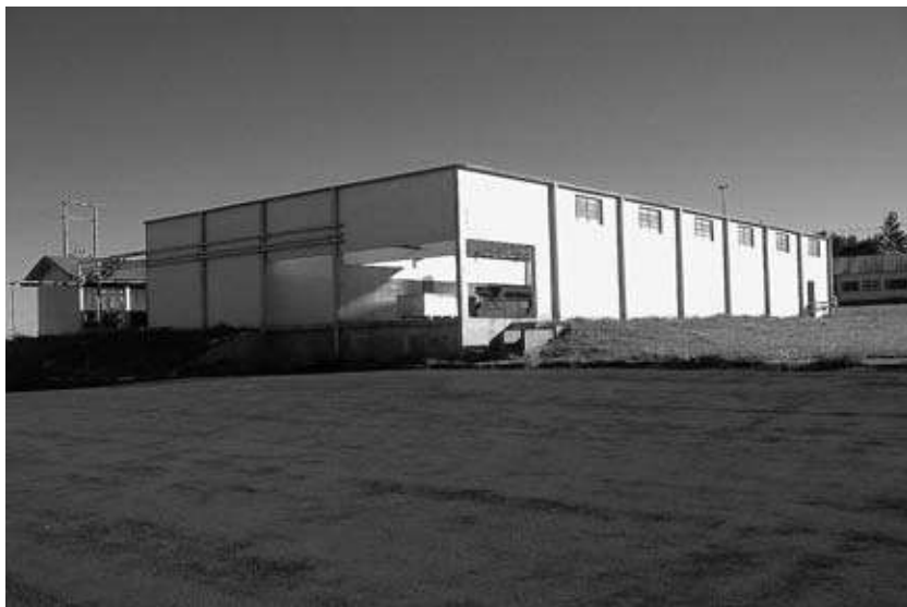
Instalación de COCAMP
