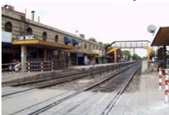
Foto N° 2. Estación San Miguel
