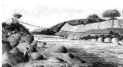
Puente del Tulumayo (Junín).
