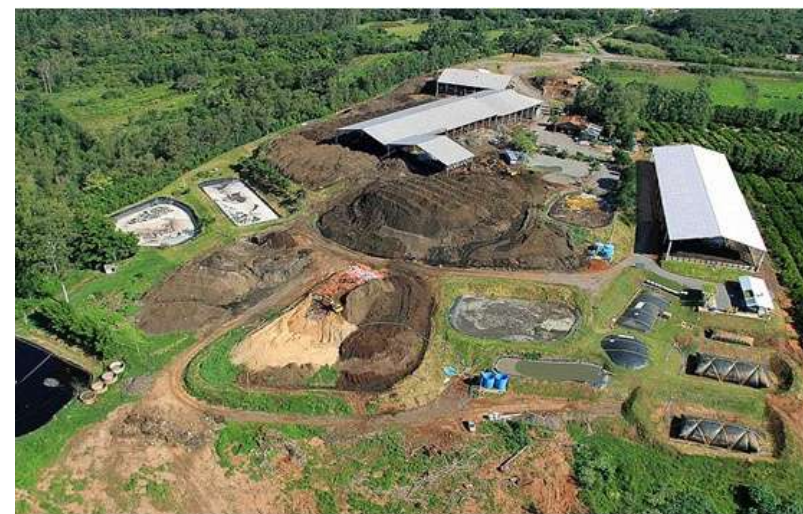
Figura 6 - Usina de Compostagem
