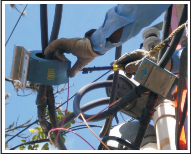
Fig. 2 Transformador de corriente instalado en el edificio 4-A.
