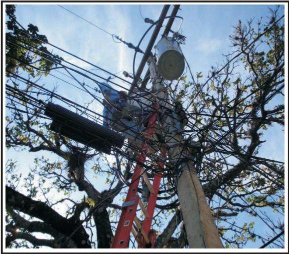
Fig. 3 Transformador de alimentación en el edificio 4-A.
