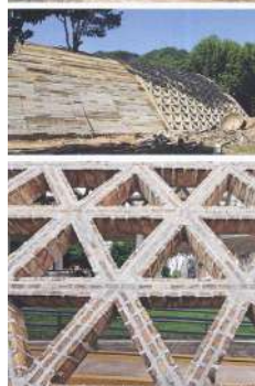
Figura 325. Fotografía de construcción de la Fundación Teletón, Solano Benítez, Paraguay, 2010.
