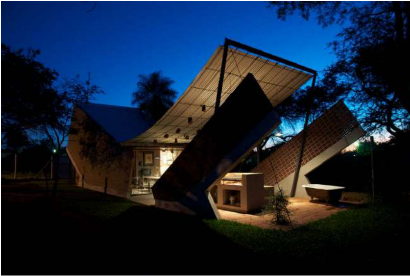
Figura 201. Fotografía de la Casa Hamaca, Javier Corvalán (Laboratorio de Arquitectura), Paraguay, 2009.
