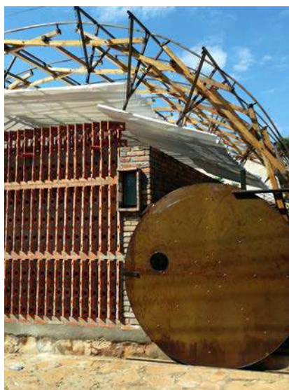
Figura 306. Fotografía de la Casa Ivapovo, Javier Corvalán (Laboratorio de Arquitectura), Paraguay, 2016.
