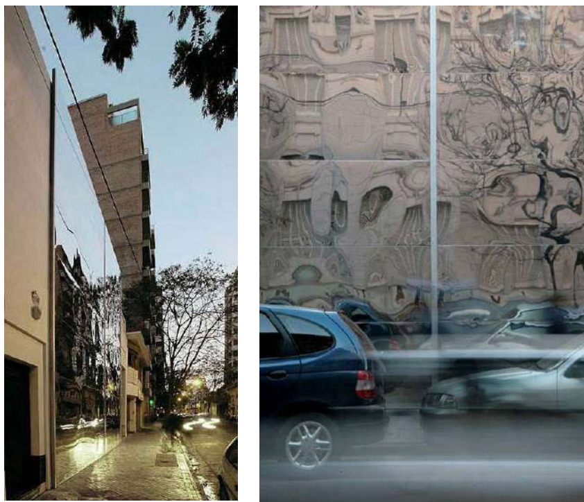
Figura 104 y 105. Fotografías de la fachada de la Clínica Proar, Rafael Iglesia, Rosario, 2008.
