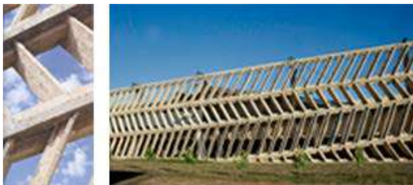
Figuras 247 y 248. Fotografías del edificio Unilever, Solano Benítez, Paraguay, 2000.
