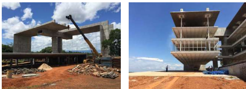
Figuras 215 y 216. Fotografías de la Itaipú en construcción, Javier Corvalán (Laboratorio de Arquitectura), Paraguay, 2016.
