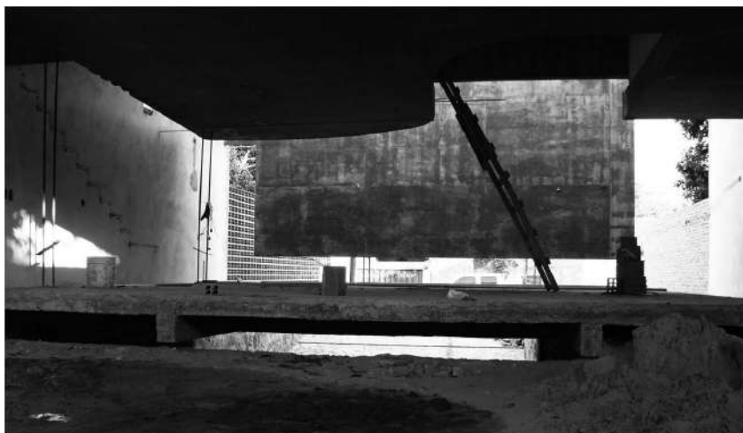
Figura 202. Fotografía de la Casa Brisco en construcción, Javier Corvalán y Andrés Careaga, Paraguay, 2009.
