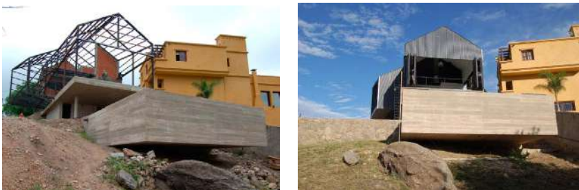
Figuras 133 y 134. Fotografías de construcción de la Vivienda Merlini ME, Ricardo Sargiotti, Córdoba, 2009.
