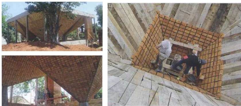
Figura 323. Fotografía de la construcción de la Fundación Teletón, Solano Benítez, Paraguay, 2010.
