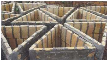
Figura 249. Fotografía de construcción de la Fundación Teletón, Solano Benítez, Paraguay, 2010.
