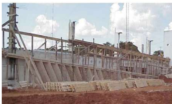
Figura 324. Fotografía de construcción del edificio Unilever, Solano Benítez, Paraguay, 2000.
