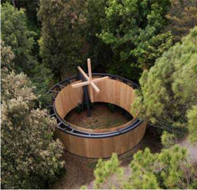
Figura 218. Fotografía de la Capilla Nómada, Javier Corvalán (Laboratorio de Arquitectura), Venecia, 2018.
