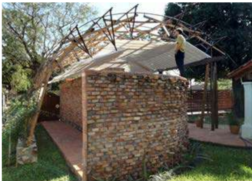
Figura 305. Fotografía de la Casa Ivapovo, Javier Corvalán (Laboratorio de Arquitectura), Paraguay, 2016.
