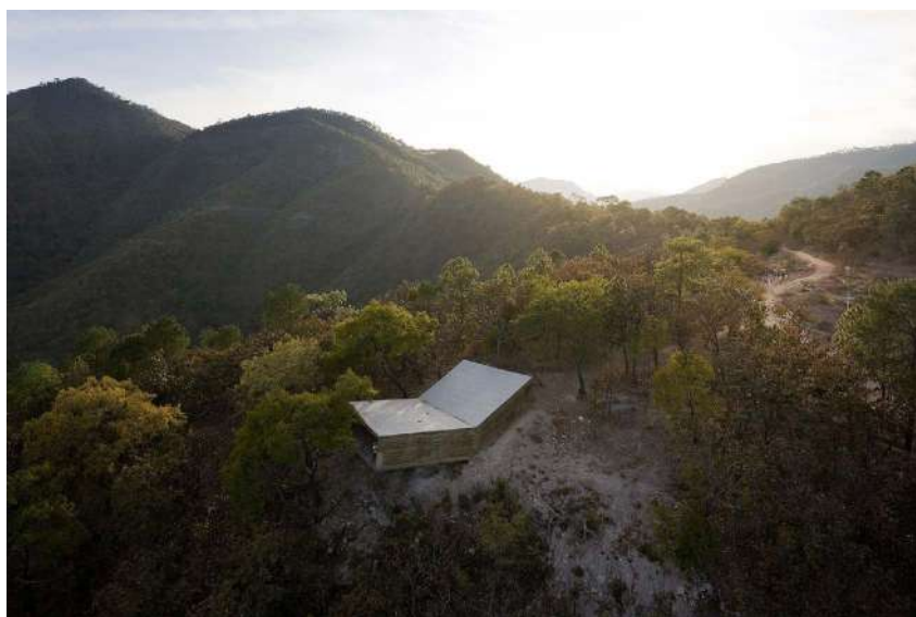
Figura 171. Fotografía del mirador Las Cruces, Alejandro Aravena (Elemental), México, 2010.
