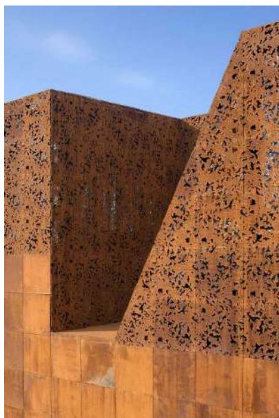
Figura 38. Fotografía de «Caixaforum», proyectada por Herzog y de Meuron. Madrid, 2007.
