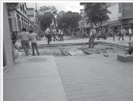
Intervenciones físicas del Bulevar (colocación de adoquines)
