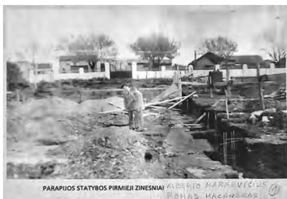
Imagen 4. Construcción de la parroquia de la Virgen de Fátima. Calles Portugal y Bélgica
