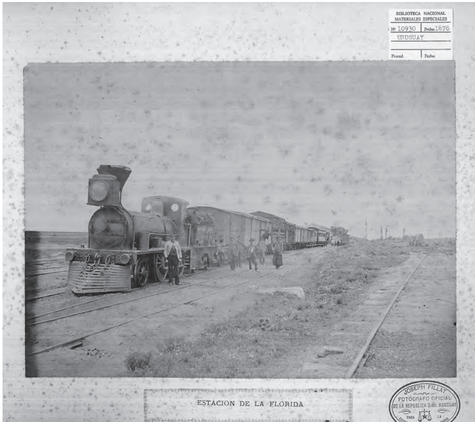
Figura 2. Estación de La Florida
