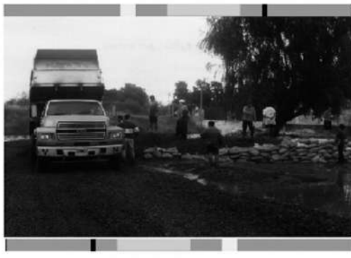
Trabajos de llenado de bolsas, ocupando la calzada norte de Av. Circunvalación
