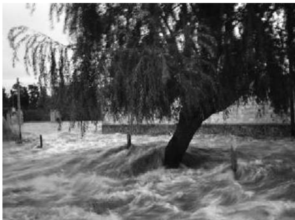
Imagen 26. Entrada de agua por brecha, 2003.
