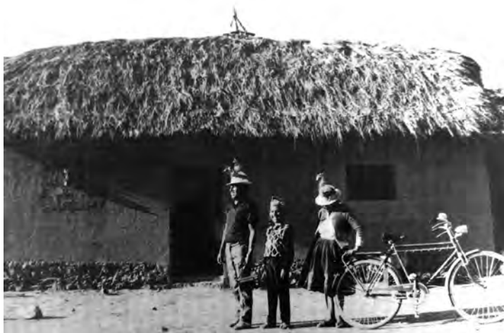
FIGURA 8A. UNA CASA TÍPICA EN QAQACHAKA CONSTRUIDA POR LA FAMILIA ESPEJO.
