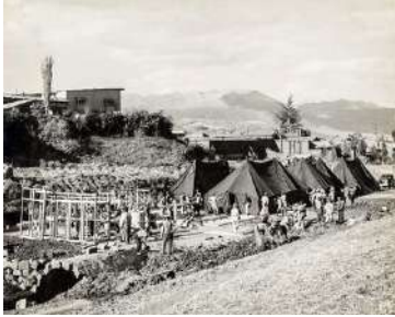
Construcción de barracas con palos de madera de eucalipto y las carpas que aún mantenían a las personas afectadas (Archivo histórico Riva Güero-Pontificia Universidad Católica del Perú), 1950-1956.
