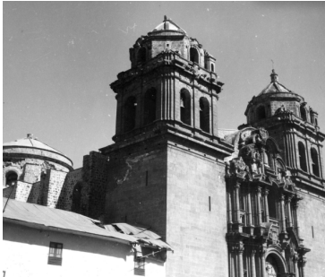
Iglesia de San Pedro, Cuzco Terremoto (CC-T-051). En esta fotografía podemos observar, los arcos y cúpulas de las torres presentaron grietas. La torre norte se inclina hacia la calle Hospital.
