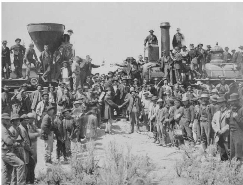
Detalle de East and West Shaking Hands at Laying Last Rail , 1869, fotografía de Andrew J. Russel. Dominio público. 71
