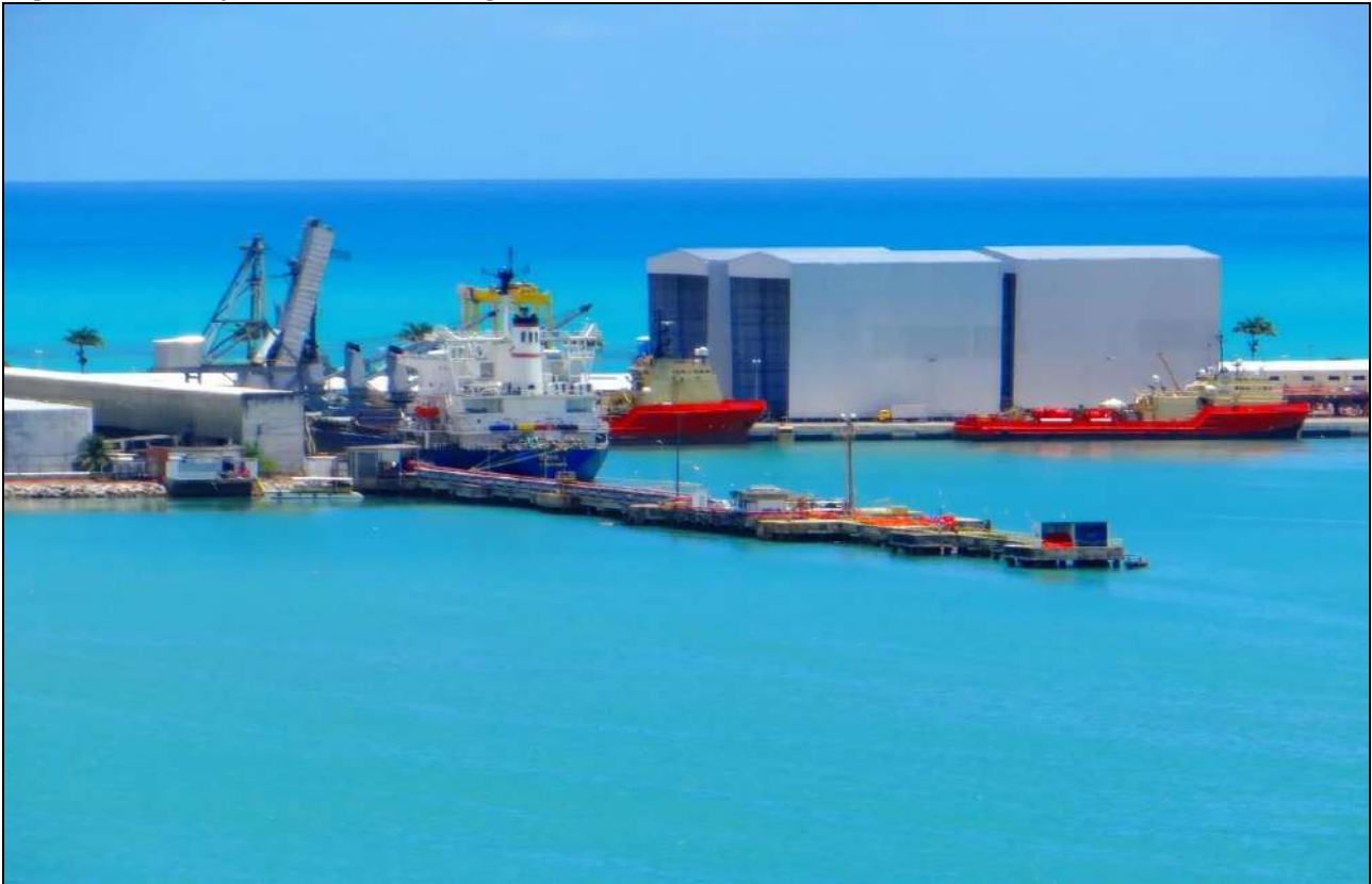
Figura 5: Instalações do Porto de Jaraguá/AL, 2017
