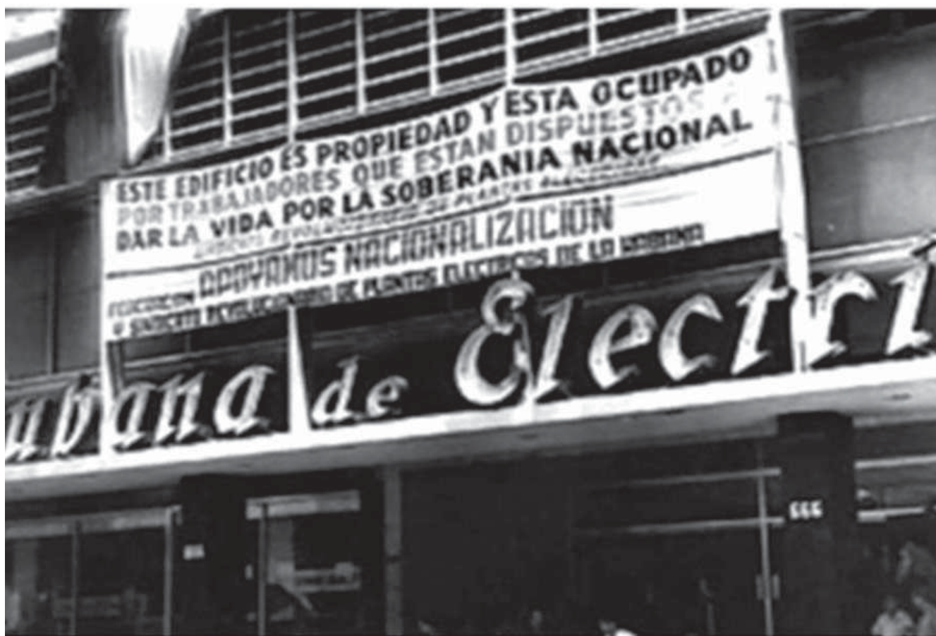
Fig. 1. Compañía Cubana de Electricidad, nacionalizada.
