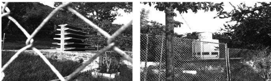
Imagen 2 y 3. Equipo de enfriamiento de las aguas termales para consumo humano
