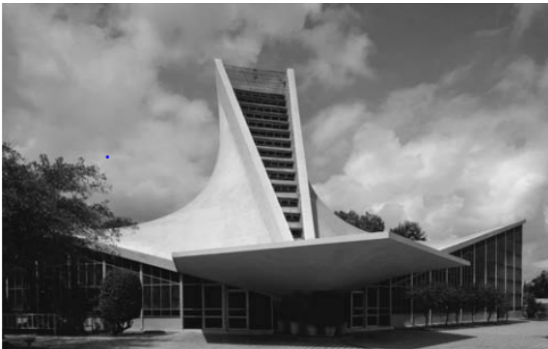
Figura 3. Iglesia de San José Obrero (1959), Monterrey, Nuevo León. Enrique de la Mora, Fernando López Carmona y Félix Candela.
