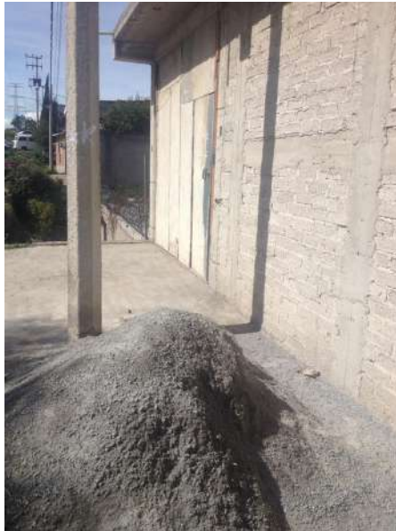
Ilustración 5. Frente de la casa de Marta con material de construcción. Colonia Techachaltitla.
