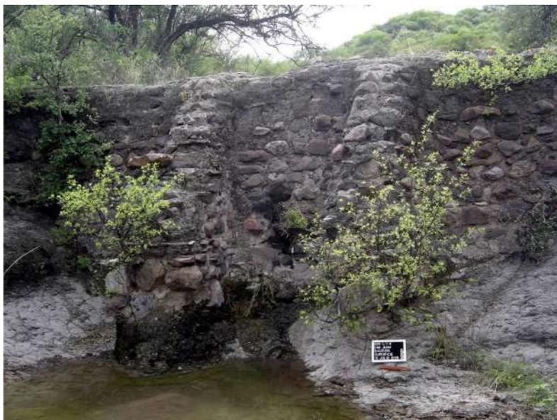
Foto 7. El muro de mampostería de la represa.
