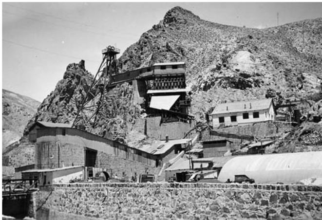
**Ánimas:** Vista de la Plataforma *El Castillo del Winche* que controla las dos jaulas (ascensores), de dos pisos cada una. Se pueden ver los buzones, la chancadora y la correa transportadora de la planta de selección.
