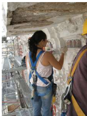
Imagen 1. Proceso de restauración de la fachada del Museo Casa de Alfeñique, 2010.
