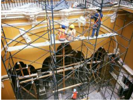
Imagen 2. Restauración de Museo Casa de Alfeñique, 2018.
