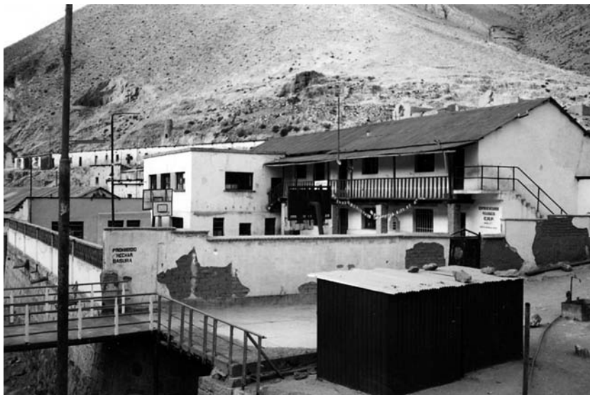
Ánimas: Vista general de la Escuela N° 3 Mariscal Sucre.
