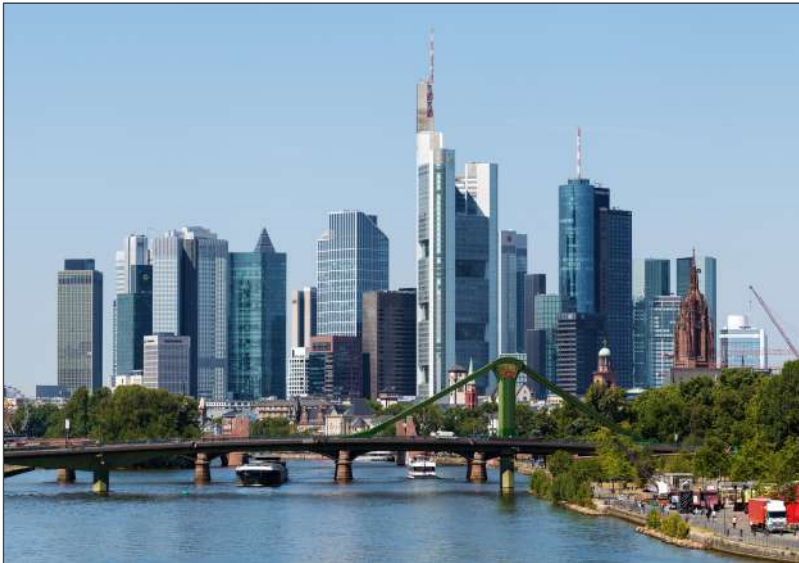
Abb. 2: Hochhäuser in Frankfurt a.M. (Deutschland),
