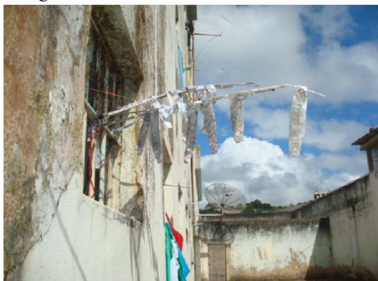
Antena artesanal feita com restos de marmitas descartáveis de alumínio
