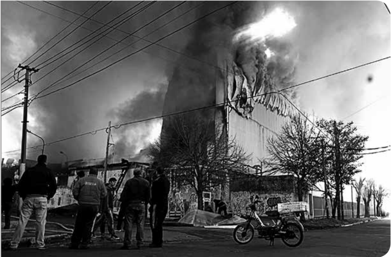
En agosto de 2013, la fábrica de embutidos Tres Cruces sufrió un incendio que destruyó el 70 % de sus instalaciones. El predio quedó en desuso hasta que fue comprado para la Universidad. Fotografía de Julieta Alfonso (cortesía de El Ciudadano del Gran Buenos Aires ).
