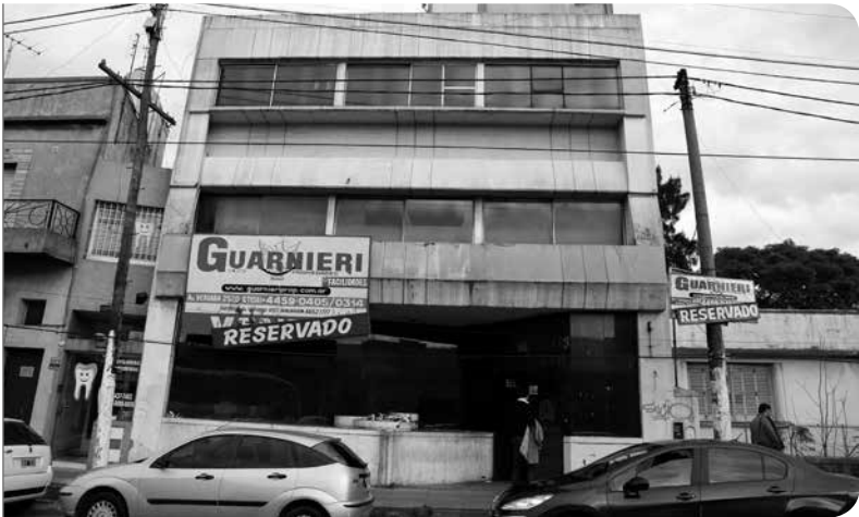
Edificio donde actualmente funciona la sede Vergara de la UNAHUR. Fotografía tomada en julio de 2015, cuando ya se había efectuado la reserva de la compra.
