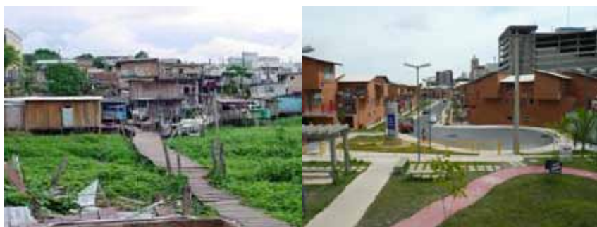
Fotos 1 e 2 - Igarapé Manaus: condições de moradia e pontes de madeira que interligam as palafitas, antes e depois da intervenção do Prosamim.
