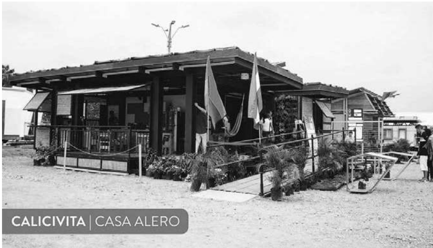
FIGURA 5.3 VISTA DEL PROTOTIPO CASA ALERO EN LA VILLA SOLAR
