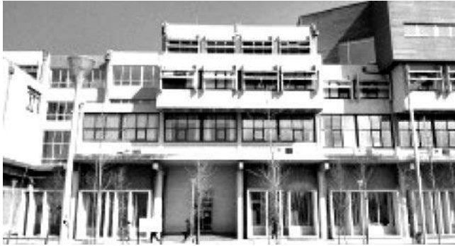
FIGURA 6.3 VISTA EN DETALLE DE LA FACHADA SUR
