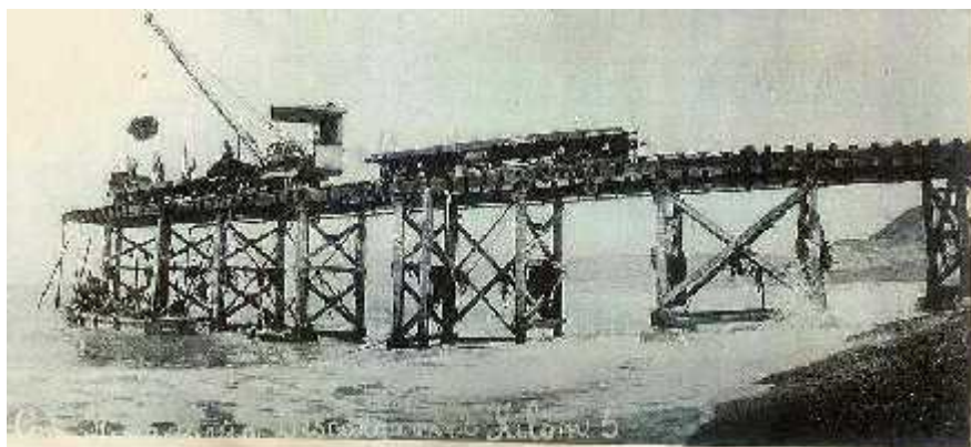
Imagen 3: Muelle ferroviario de Km. 5 en plena actividad. Fuente: Asociación de Rescate Histórico “Detrás del Puente”.
