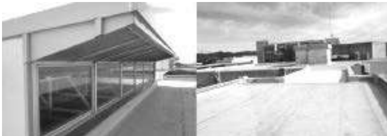
FIGURA 6.5 CUBIERTA DEL EDIFICIO
