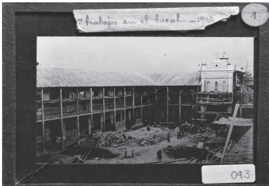
Construcción del local escolar (1904). Fuente: Escuela Tecnológica Instituto Técnico Central
