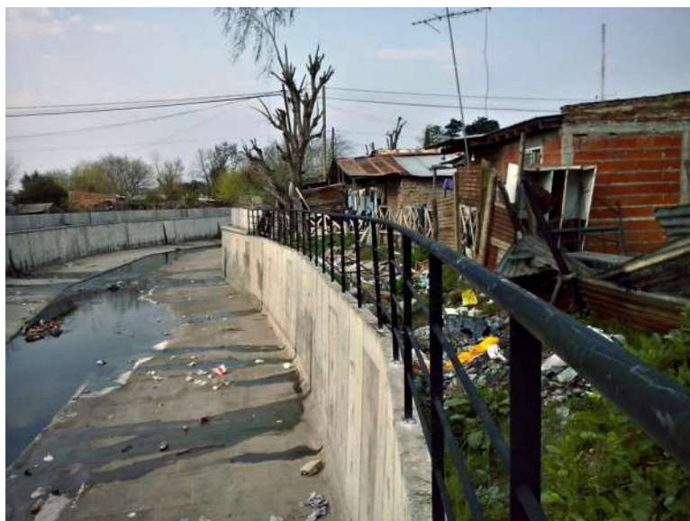
Fotografía propia en la que puede verse la barrera de metal que se colocó en reemplazo del muro de hormigón del resto del canal.
