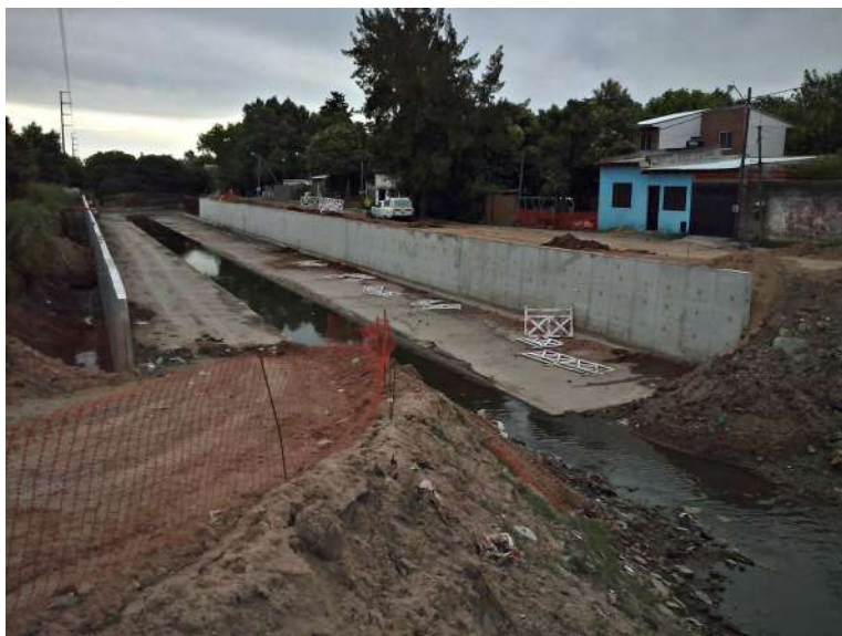
Fotografía propia tomada desde el inicio del tramo once de la obra, sobre el puente de la Avenida 137 en dirección hacia el barrio. En ella pueden observarse la base del canal, los muros de contención de hormigón y el pequeño caudal de agua que corre en el centro.
