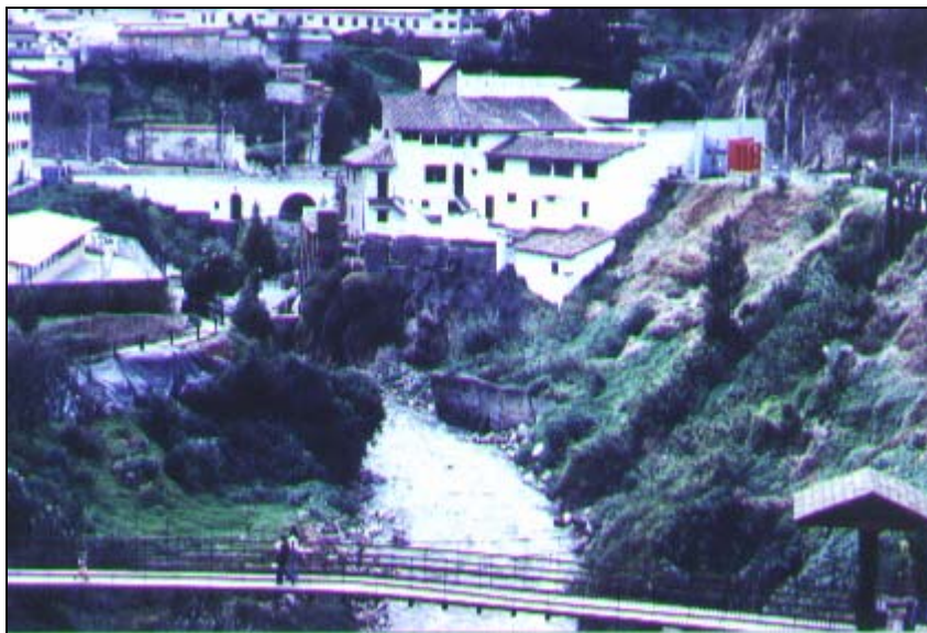
Puente sobre el Río Machángara, parque Lineal
