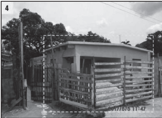
1: vivienda medianera. 2: vivienda esquinera con cubierta ligera. 3: vivienda con medianería en uno de sus laterales. 4: vivienda aislada con cubierta pesada, en este caso la célula básica se desarrolla paralela a la vía. Fuente: Archivo personal, 2017.
