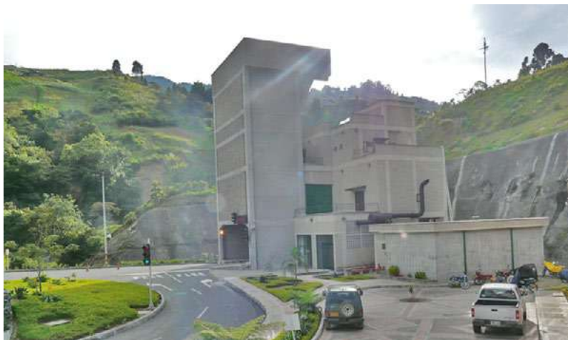
Figura 29. Fotografía de inicio del Túnel de Occidente
