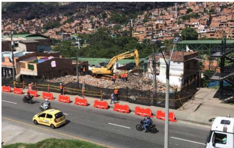
Figura 43. Demoliciones en el barrio la Paralela
