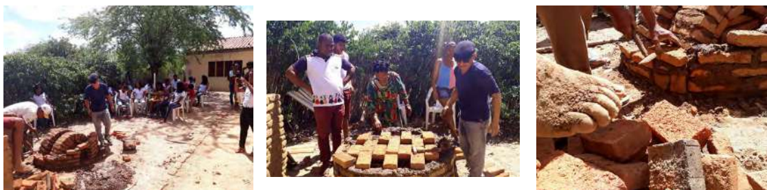
Figuras 10-12 Construção do forno em execução
