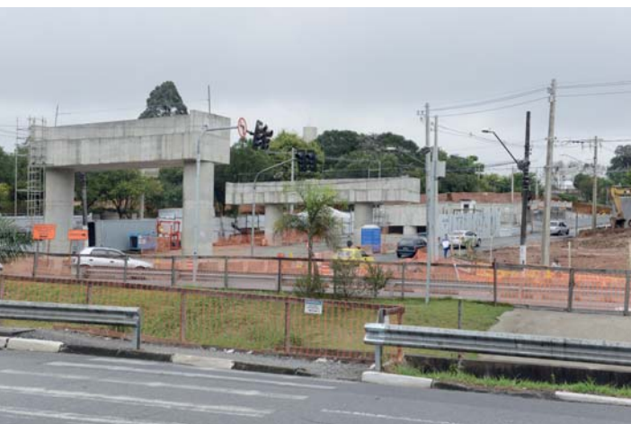
Um dos 12 corredores de ônibus (obra leste-oeste).
