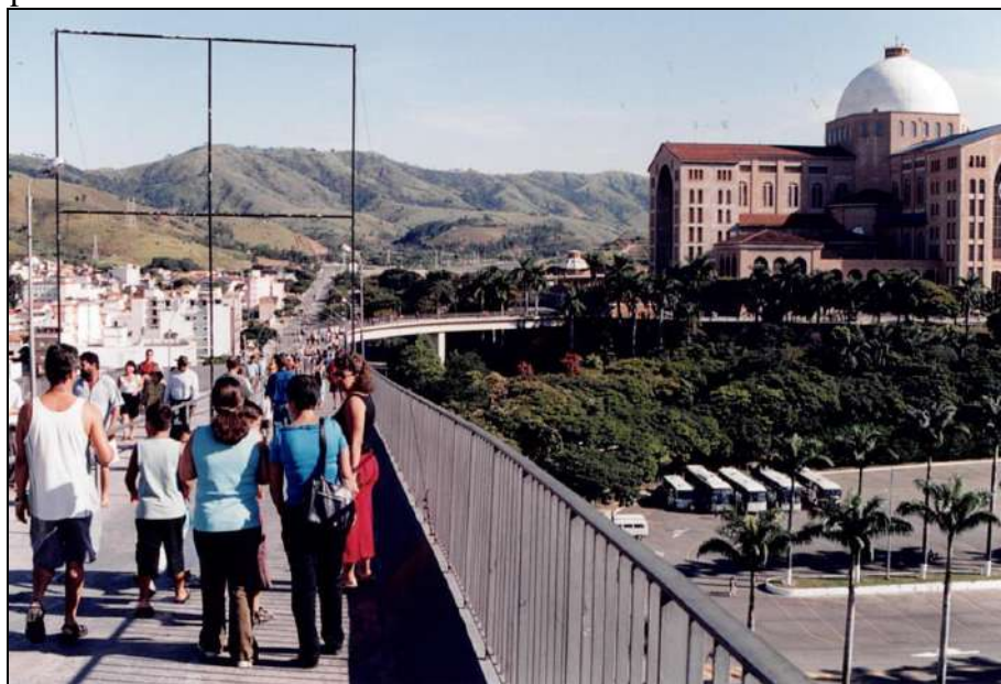
Figura 02: Visão geral da separação entre a Basílica e a Cidade, pela passarela.
