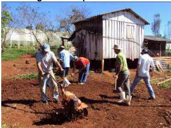
Figura 1: Preparo da base
