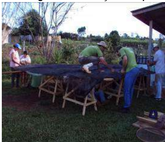
Figura 6: Construção do topo
