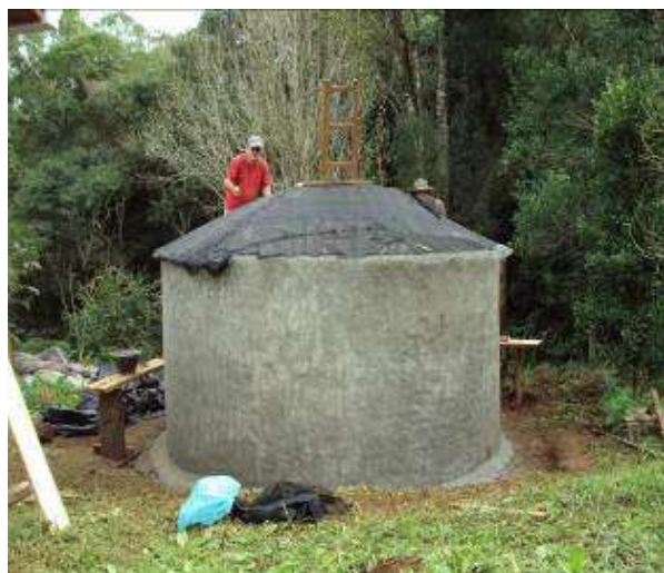
Figura 10: Topo pronto para fixação da massa
