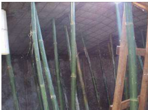
Figura 8: Bambus de apoio para fixar o topo
