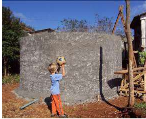
Figura 4: Parede com massa
