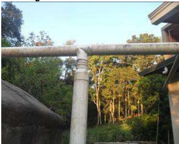
Figura 12: Sistema de descarte
