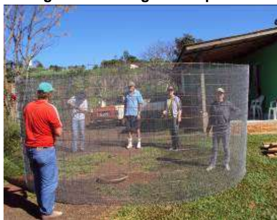
Figura 2: Montagem das paredes
