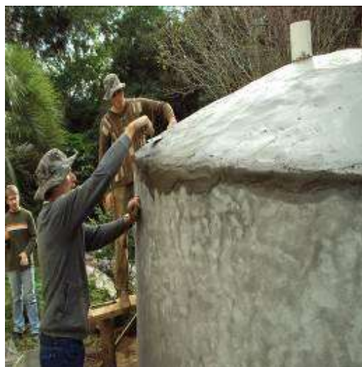
Figura 11: Fixação da massa
