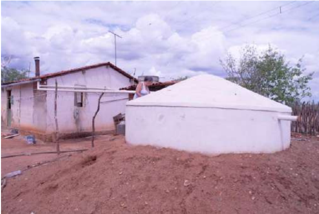
Foto 1: Cisterna de placas no município de São João do Cariri-PB
