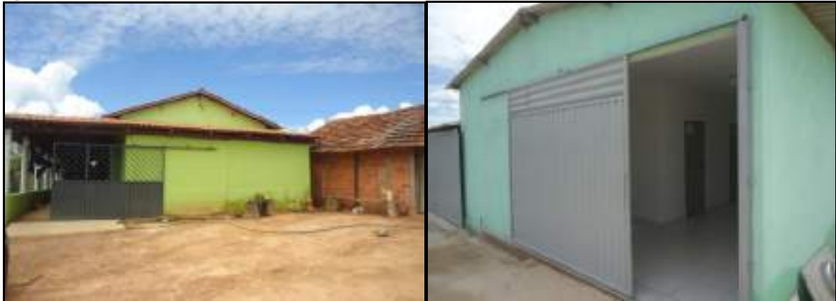
Figura 04: Visão externa da casa e da padaria rural
